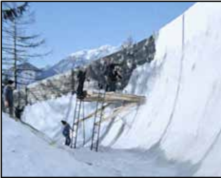
Die Eisblöcke für die Bob- und Rodelbahn in Igls wurden mittels Motorsägen aus dem Lanser- bzw. Herzsee geschnitten und im Eiskanal „vermauert“.
