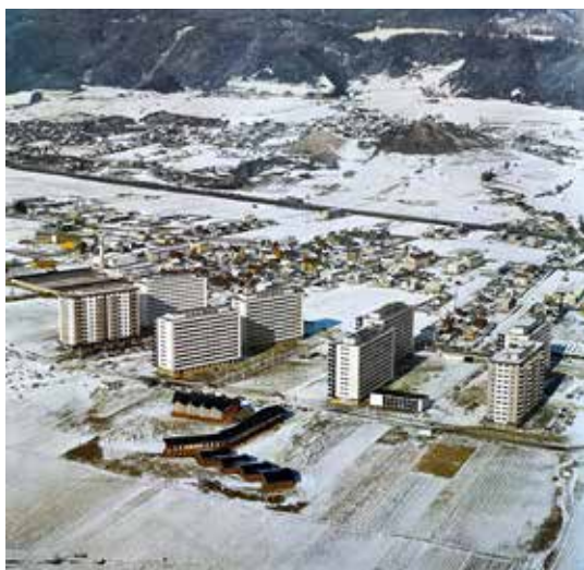
OLYMPISCHES DORF 1964: „DIE GRÖSSTE BAUSTELLE, DIE INNSBRUCK JE GESEHEN HAT.“
