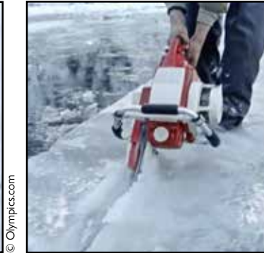
Die Eisblöcke für die Bob- und Rodelbahn in Igls wurden mittels Motorsägen aus dem Lanser- bzw. Herzsee geschnitten und im Eiskanal „vermauert“.
