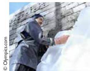
Die Eisblöcke für die Bob- und Rodelbahn in Igls wurden mittels Motorsägen aus dem Lanser- bzw. Herzsee geschnitten und im Eiskanal „vermauert“.
